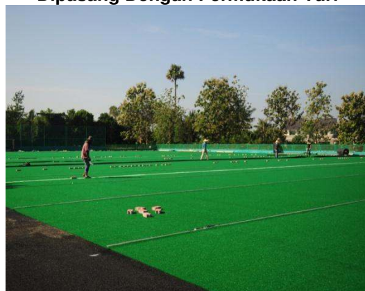
Gambar 3.2 Keadaan Gelanggang Hoki Yang Sedang Dipasang Dengan Permukaan Turf
