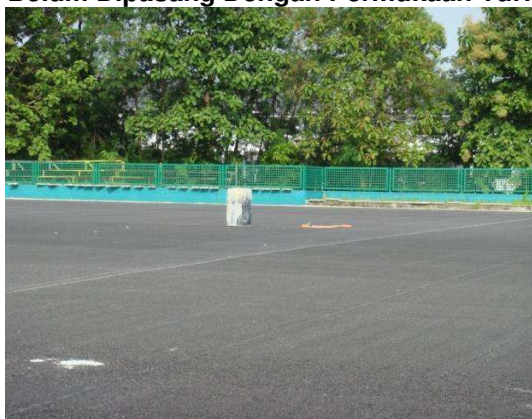
Gambar 3.1 Keadaan Gelanggang Hoki Yang Masih Belum Dipasang Dengan Permukaan Turf
