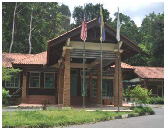
Gambar 2.14 Bangunan Utama Pusat Rawatan Dan Spa Yang Belum Beroperasi
