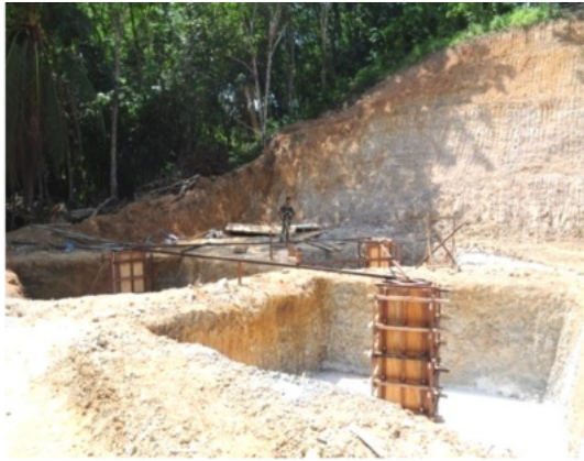
Gambar 4.3 Tapak Menara- Bukit Chabang Dalam Proses Pembinaan
